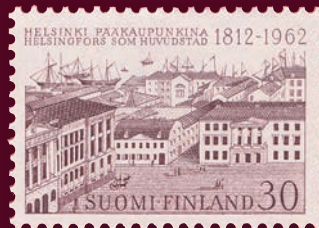
Senatstorget med sine vakre bygninger på frimerke fra 1962.
